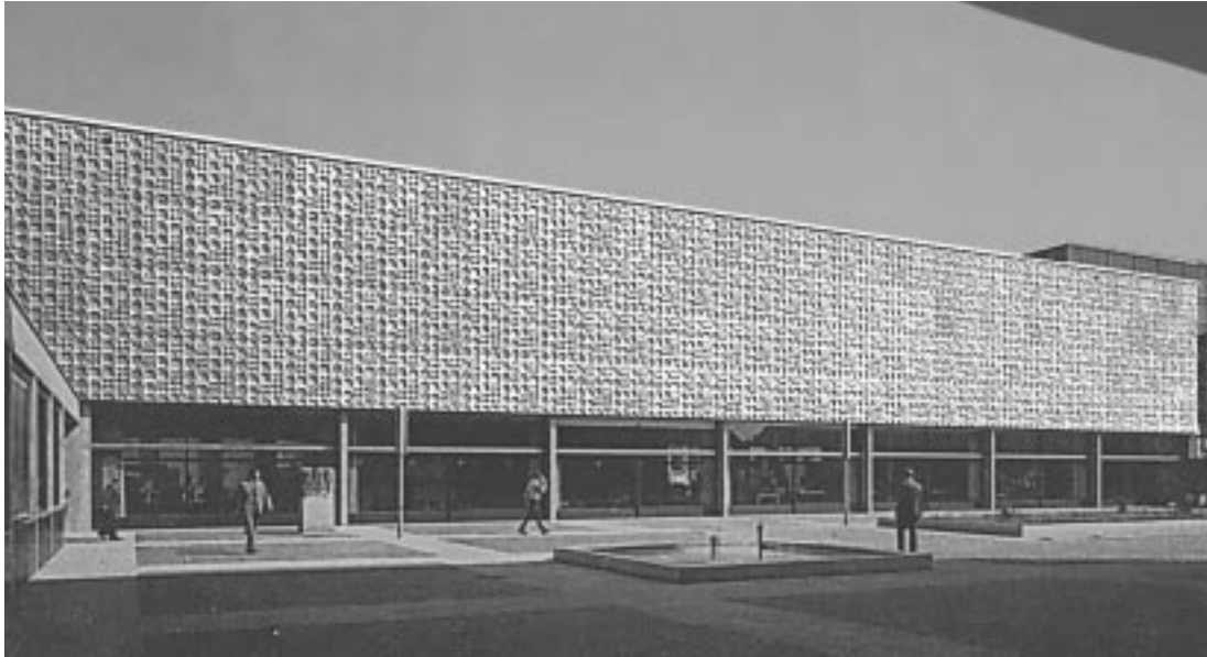
Das Josef-Haubrich-Forum mit der legendären Kunsthalle und dem Kölnischen Kunstverein, 1967 von dem Kölner Architekten Franz Lammersen errichtet, soll im Juli 2002 abgerissen werden. Die Qualität des Neubaus ist umstritten.
